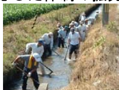
水路の泥上げ
